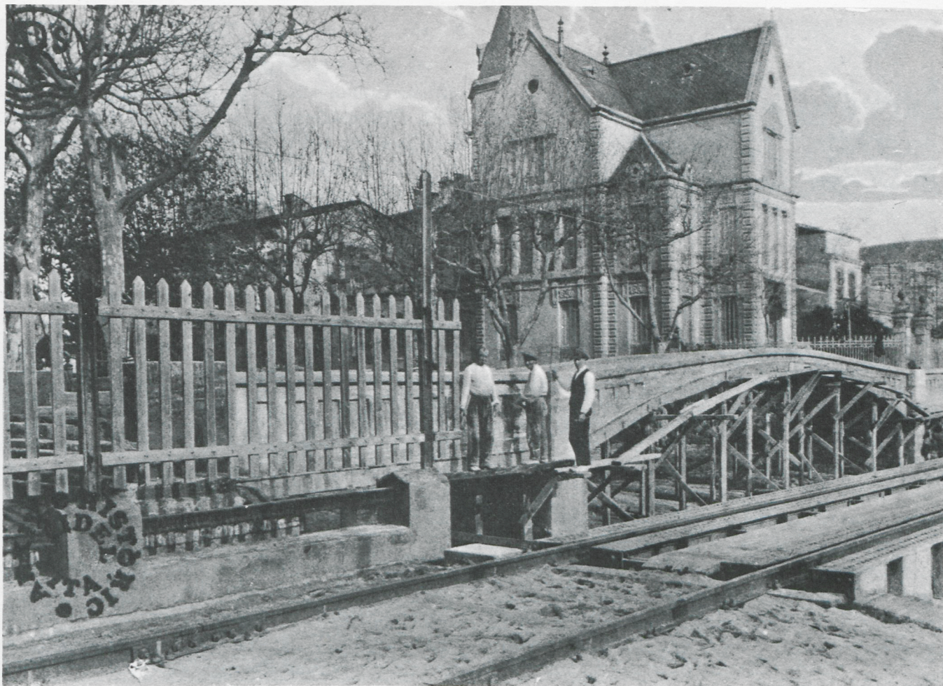
El pont en construcció. Any 1921.
